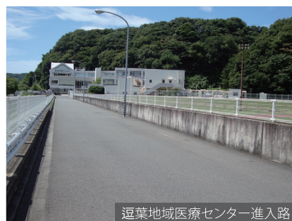
逗葉地域医療センター進入路
